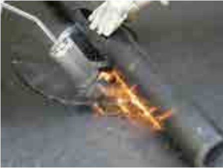
4. İkinci bitüm folyeyi süzgecin bitüm manşetiyle bağlayın
