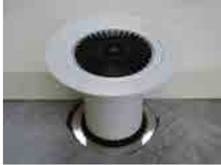
8. Isı yalıtımını kesip döşeyin, yükseltme parçasının yüksekliğini kısaltarak ayarlayın
