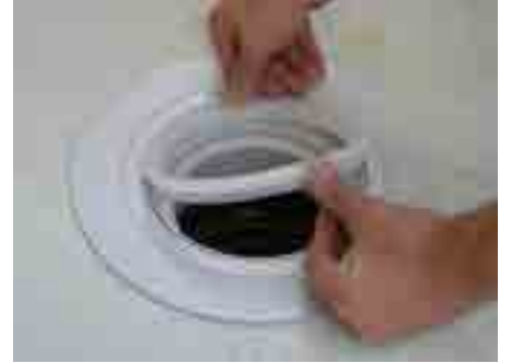
9. Şeffaf plastik contayı flanşın üzerine yerleştirin
